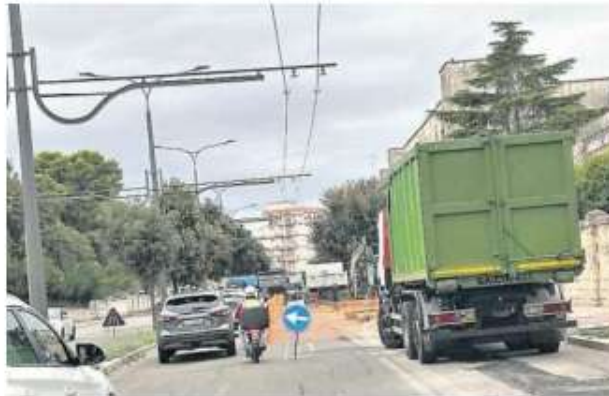
Una via di Lecce interessata dai lavori stradali
